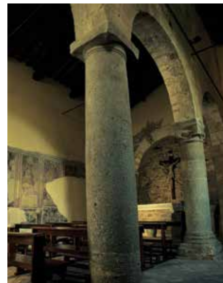
San Piero, chiesa romanica
